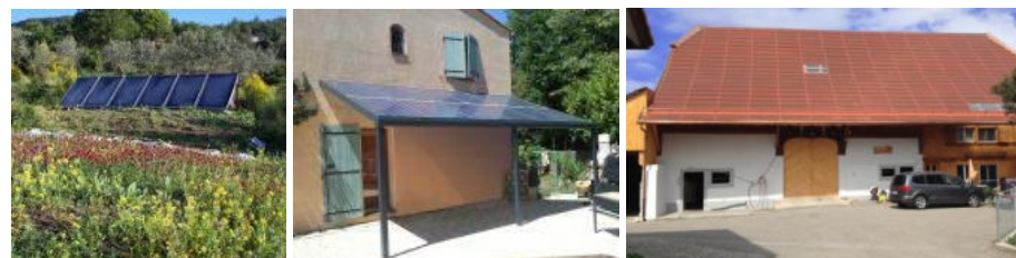
Panneaux au sol, en auvent et sur 100% d'une toiture principale et de couleur rouge
