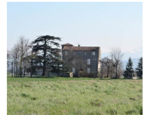
Maison forte du Fort
