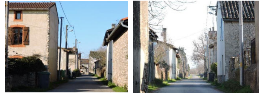
Constructions perpendiculaires à la voie laissant percevoir les jardins
