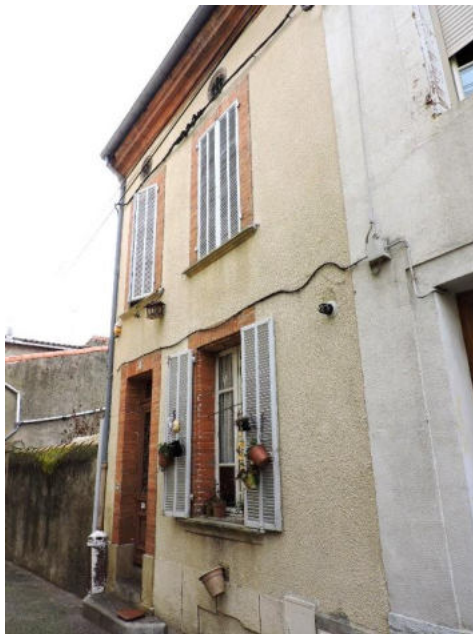
Maison de bourg (19 e siècle) 26 rue Maurice Eychenne
