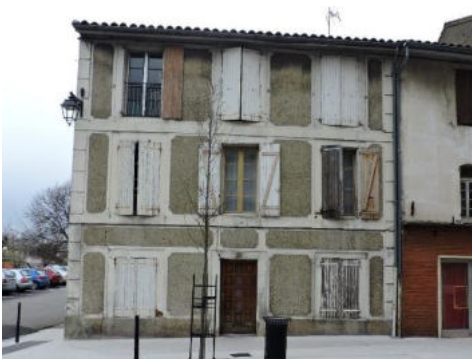
Maison de bourg (médiéval/19 e siècle), 3 rue des Carmes
