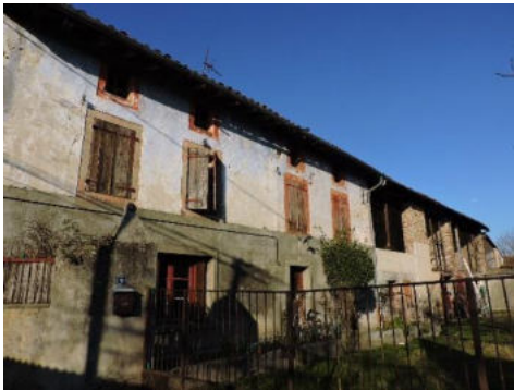
Maison rurale (19 e siècle) à Trémège
