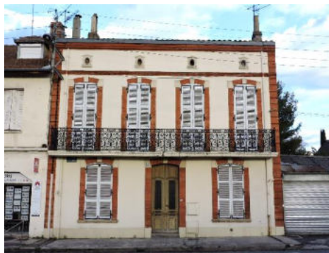
Maison de bourg (19 e siècle) 70 boulevard d'Alsace-Lorraine
