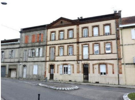
Maison de bourg (19 e siècle) 4-8 rue de Terrassa
