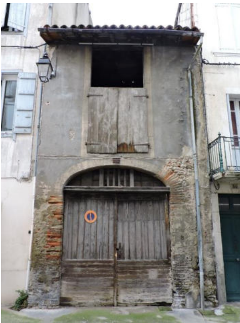
Remise (18 e /19 e siècle) 33 rue Lakanal
