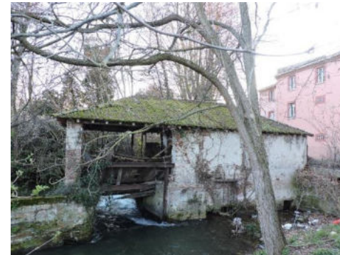
Ancien moulin de la Cagne, chemin de Bourges
