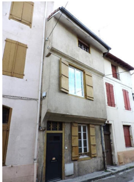
Maison de bourg (médiéval) 15 rue Piconnières
