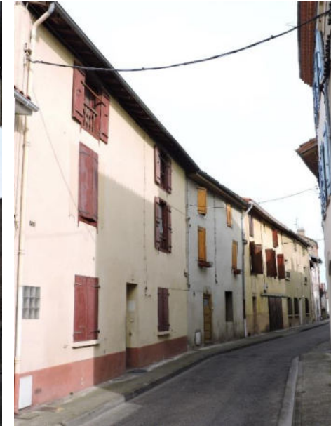
Succession de façades larges de même gabarit (rue de la Papèterie)
