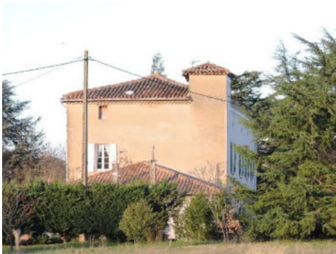
Maison forte à Bourges (17 e /18 e siècle), chemin de Bourges
