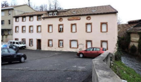
Ancienne papèterie de Lestang (19 e siècle), 37 bis rue de la Papèterie
