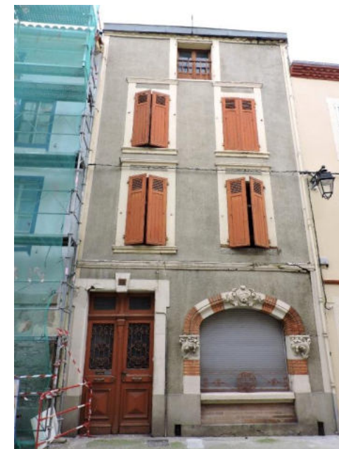
Maison de bourg (19 e /20 e siècle) 55 rue Lakanal
