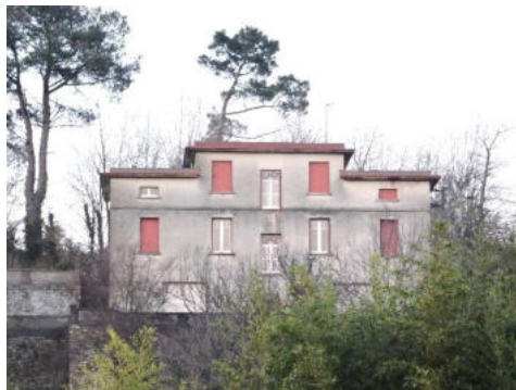
Villa (20 e siècle) 21 rue de Villeneuve. Art déco
