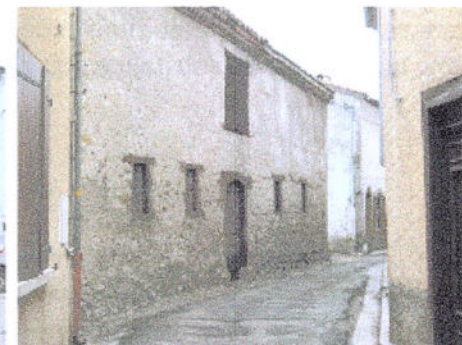
Maison ancienne à encadrements de bois
