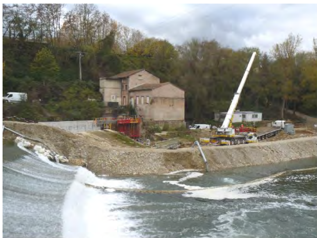
Centrale hydro-électrique, actuellement en travaux
