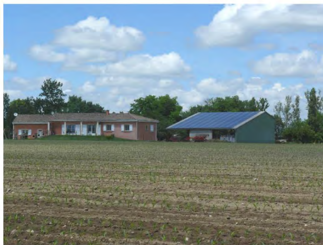
Hangar agricole (avec panneaux photovoltaïques) à Saint-Michel»
