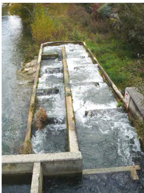
Passe à poissons sur l'Hers en face de la centrale
