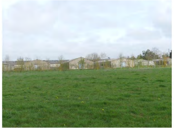
Vue sur l'ancienne porcherie depuis la prairie pacagée des abords sud-ouest
