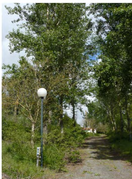
Eclairage à boules opales dans le camping
