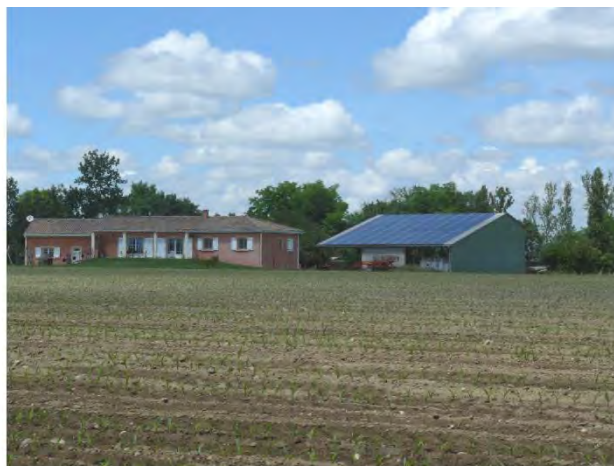
Hangar agricole (avec panneaux photovoltaïques) à Saint-Michel»
