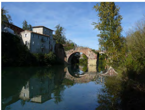
Pile de l'ancien pont sur l'Hers
