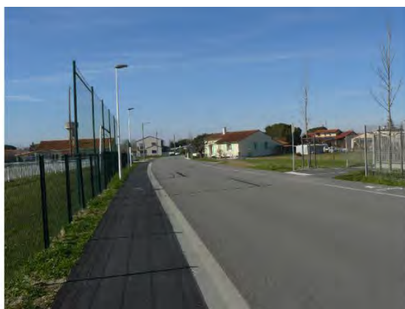
Rue avec trottoirs aux normes (chemin de Couloumier)
