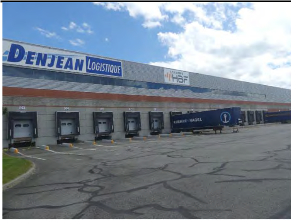
Bâtiment industriel de logistique au nord du site
