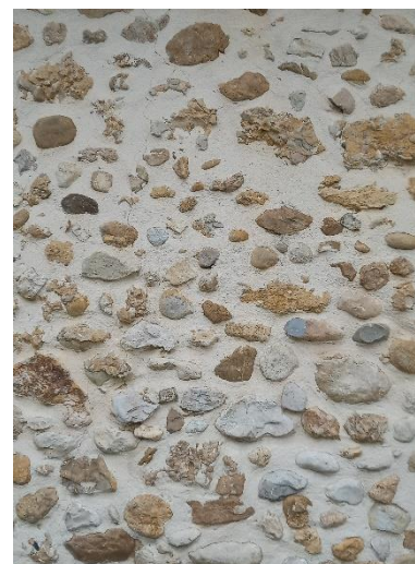
Mur en pierre
