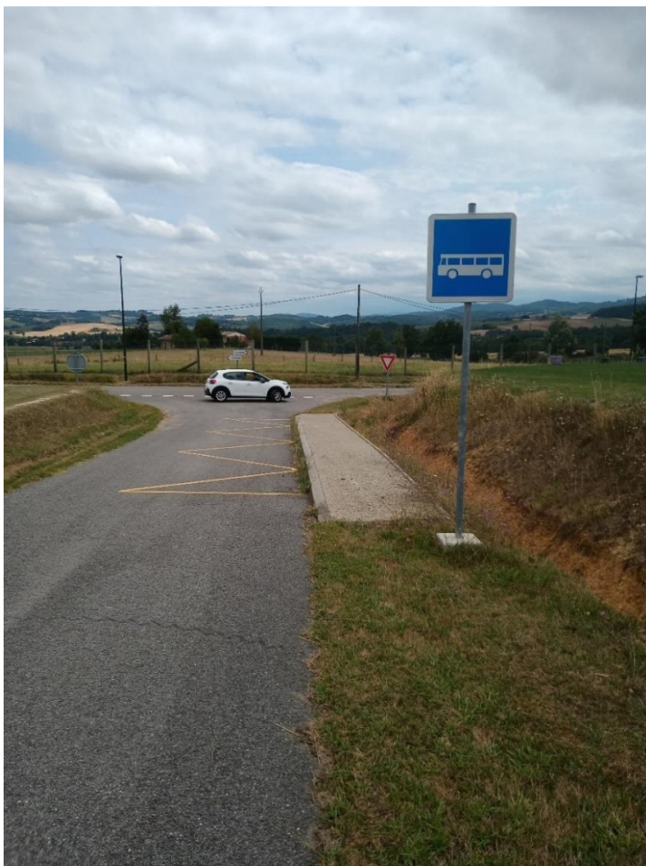
Arrêt de bus sur la commune de Madière
