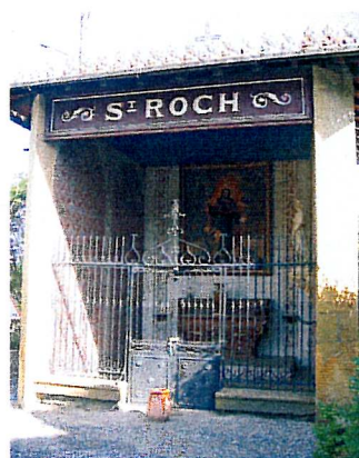
Chapelle St-Roch - toit en croupe
