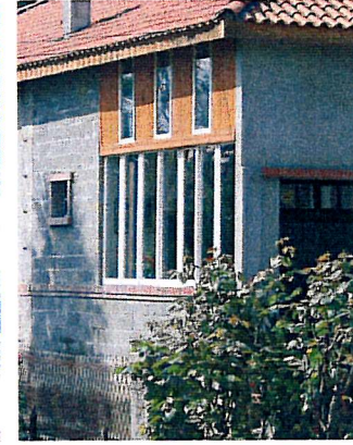
Réfection de l'entrée - baie vitrée
