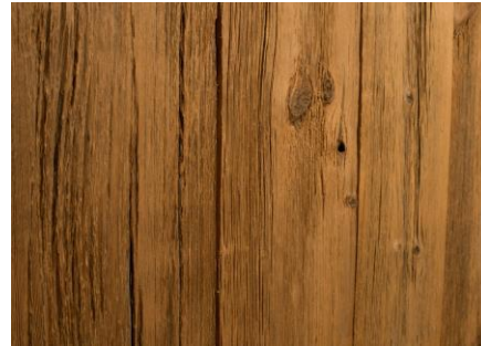
Mur en bardage bois
