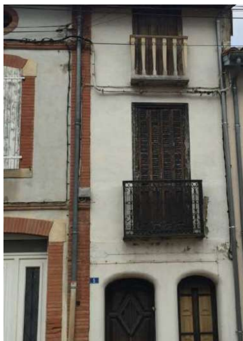
Arcs plein cintre au RDC
