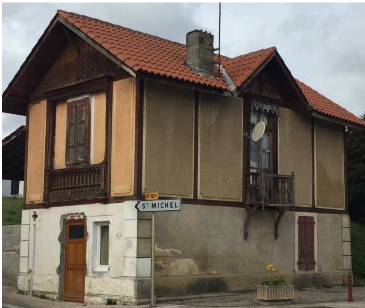
Centre ancien, avenue des Pyrénées
