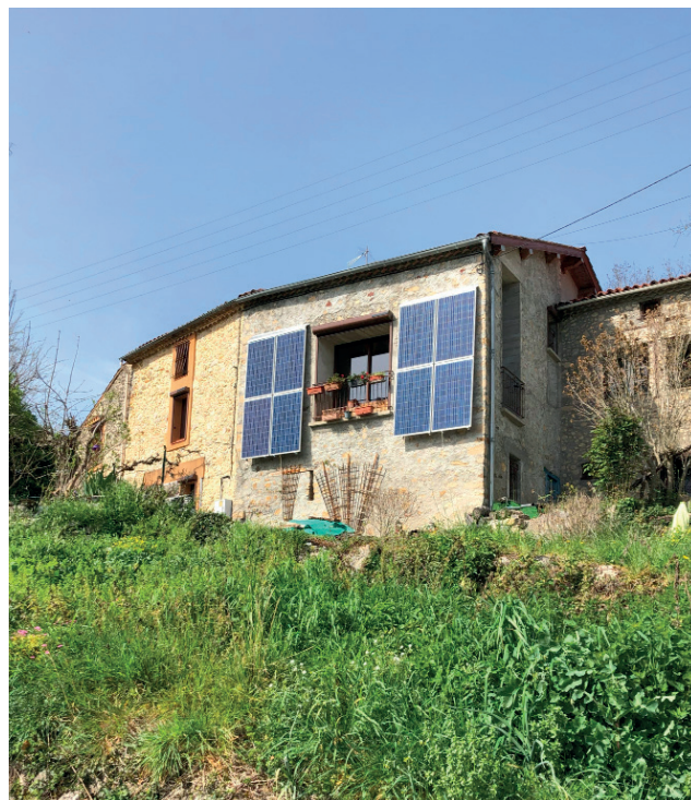
Installation de panneaux solaires en façade
