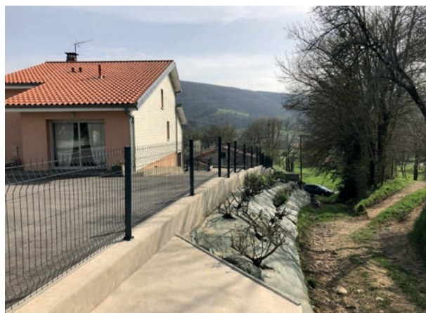
Déblais-remblais important pour l'implantation d'un pavillon en belvédère au hameau de Ponsou
