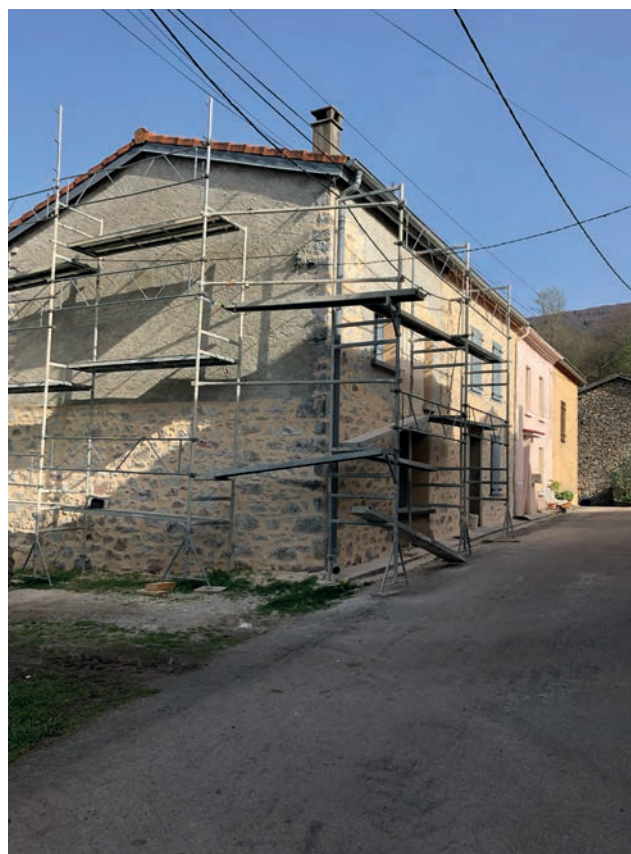
Reprise de l'enduit
