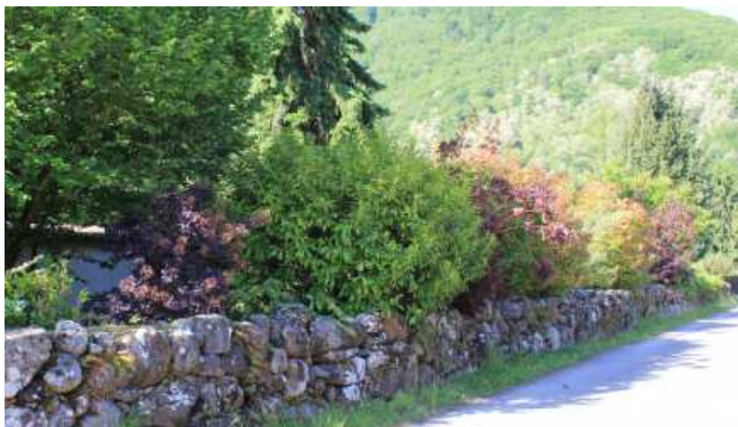
Muret et haie de clôture favorable
