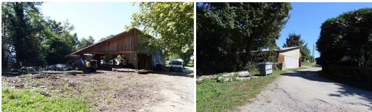
Scierie - Entrée habitation est, espace public du container
