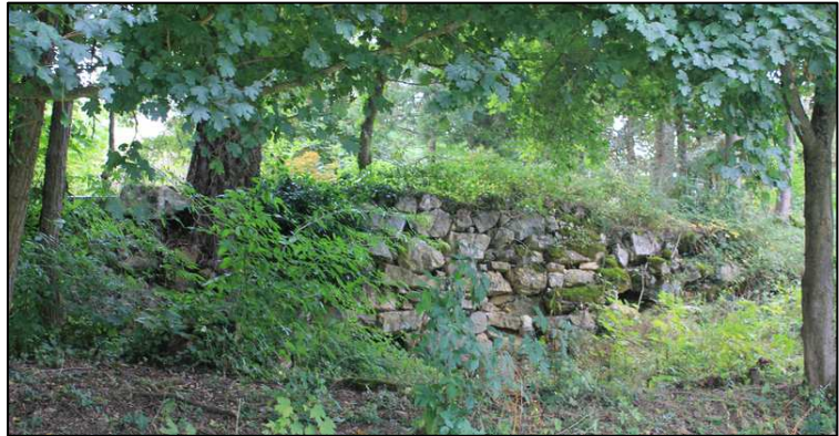
Muret à Montcru
