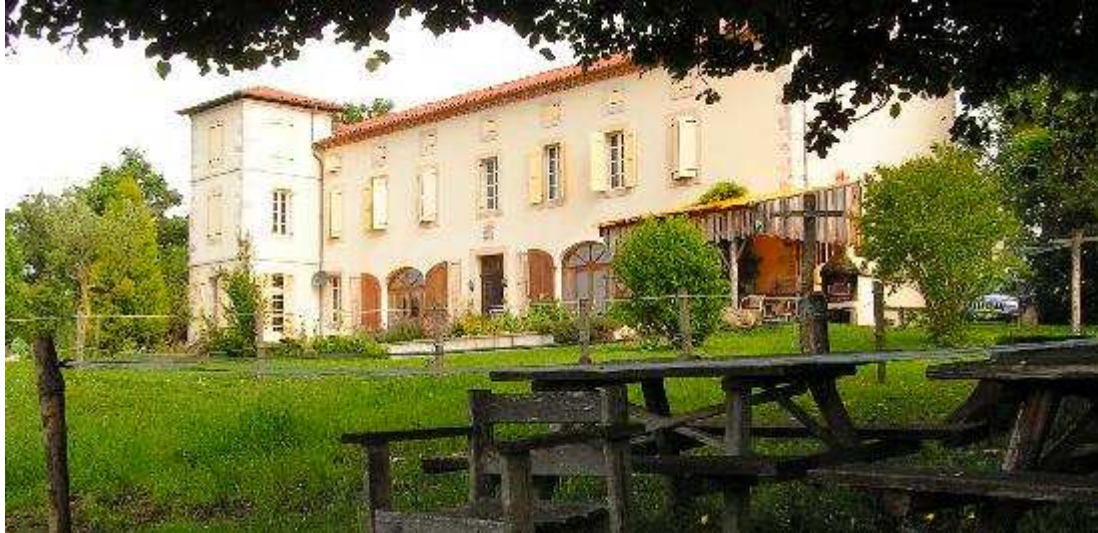
Château de Montcru avant l'extension en façade principale.
