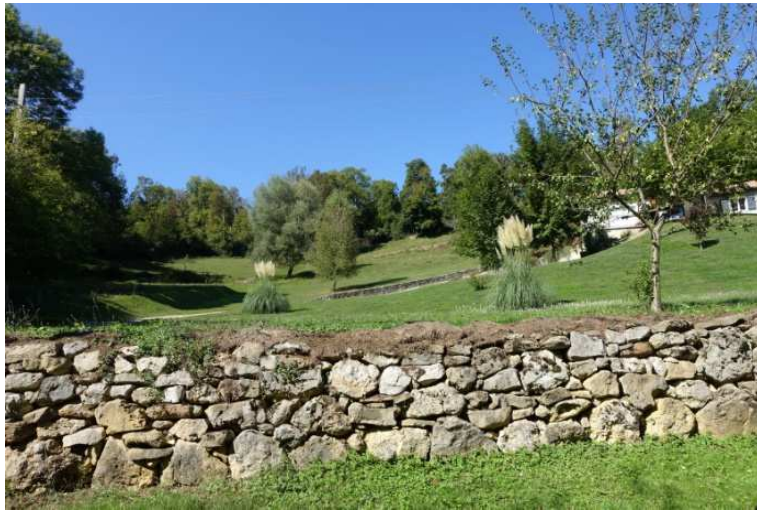
Mur de soutènement type pierre sèche à Escougnals
