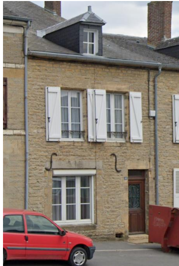
Elargissement de la fenêtre au rez-de-chaussée
