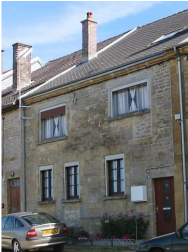
Elargissement des fenêtres à l'étage
