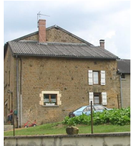
Création de fenêtre sur le pignon
