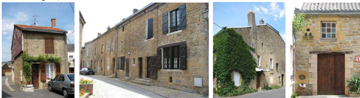
Le bâti ancien en moellons de schiste
