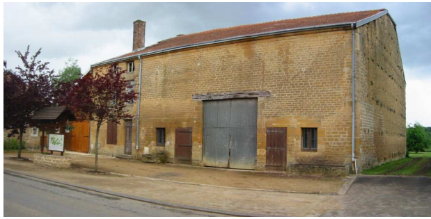
Ferme communale rue de Prahaie
