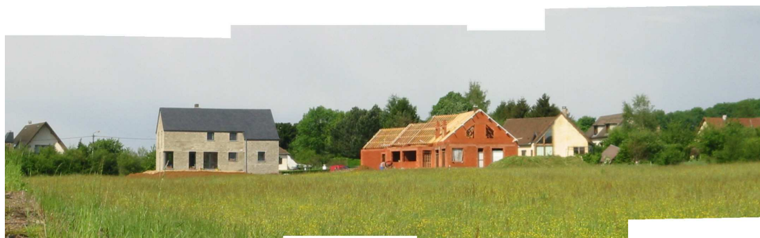
Chemin des Voiselles.. Vue depuis le cimetière sur l'arrière des dernières habitations en cours de construction ( accession à la propriété ).
