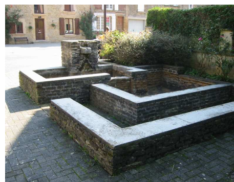
Lavoir rue de la Citadelle
