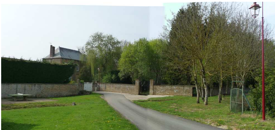
Ensemble bâti formant « Le Moulin » rue du Moulin, avec ses murs de clôture – parcelle AB 327
