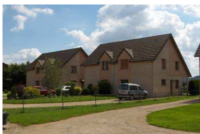
Petit collectif récent rue de la Gare.
