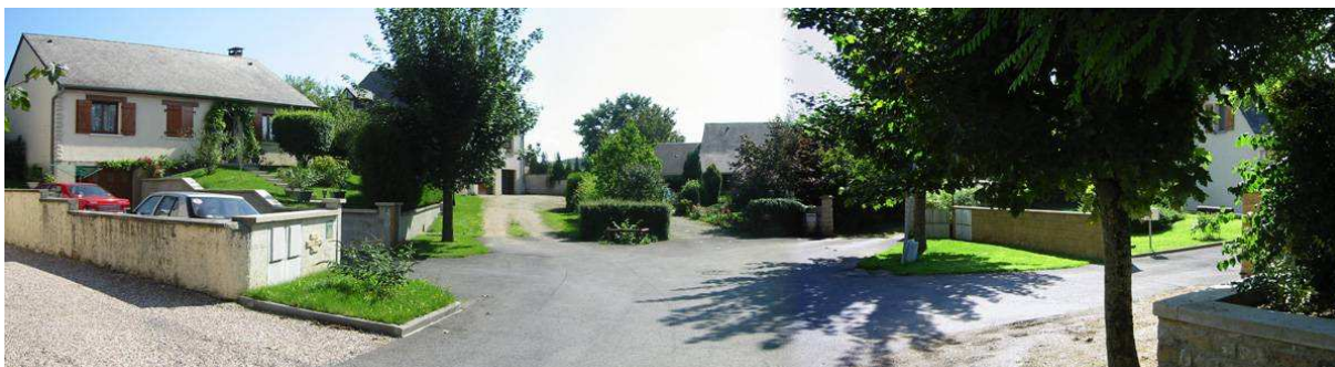
Vue sur la "raquette" desservant les habitations pavillonnaires. Les maisons sont constituées d'un sous-sol + combles.
