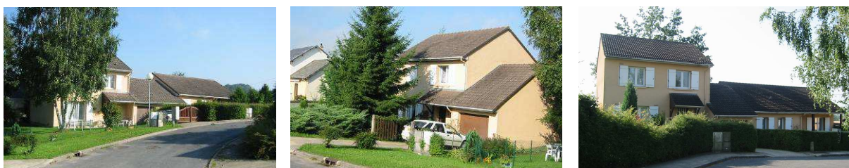
Les maisons sont isolées sur la parcelle ou mitoyennes. Leur hauteur varie du rez-de-chaussée au R + 1.
