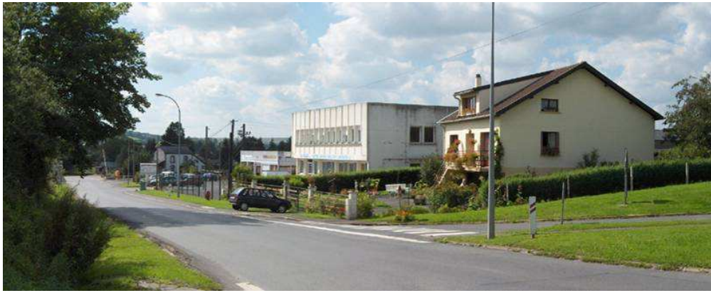
Les habitations côtoient les activités industrielles et artisanales, rue de la Gare.
