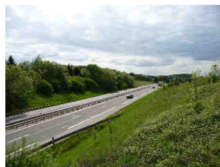
Franchissement de la N.1043 au niveau du chemin des Romains
