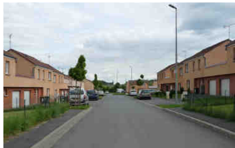
Lotissement excentré Le Clos de la Garenne
