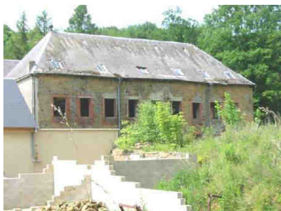
Ancienne marbrerie en cours de rénovation
