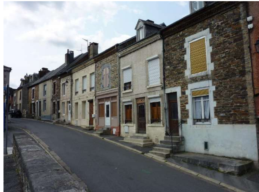
Le bâti ancien de Reviv est jointif et permet ainsi une grande inertie thermique. Ce bâti massif joue un rôle de stockage et de régulation thermique en saison froide, et offre aussi un excellent confort d'été.
