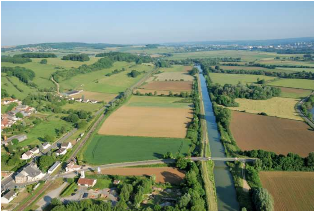
Vue sur le pont de la Meuse en venant de l'Auberge du Port et de Bazeilles avec à gauche la vue sur une partie du hameau d'Aillicourt
