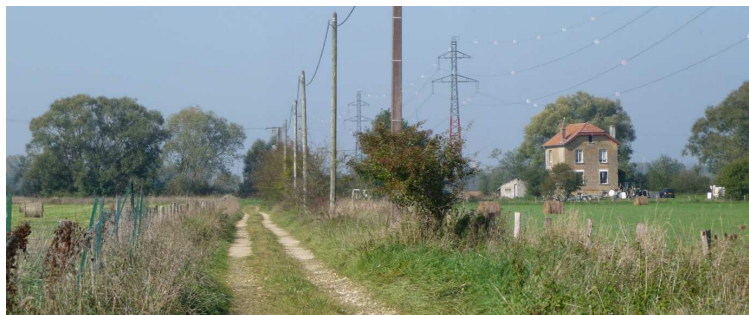
Vue sur une ancienne ferme en frange du territoire de Douzy, desservie par le chemin de la Bonne Fache, à usage actuel d'habitation.
