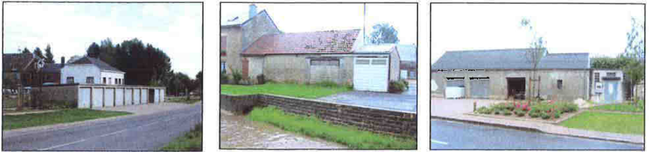
Manque d'intégration des bâtiments dans leur environnement immédiat ( volumétrie, matériaux, ... ).
