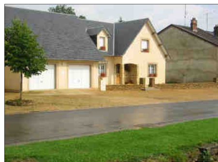
Construction récente dans une dent creuse du centre ( Grand'Rue )
