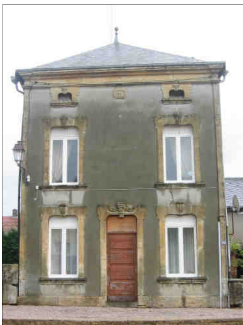
Grand' Rue . Construction de 1887.
