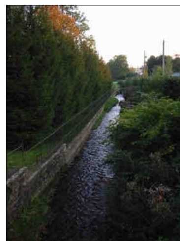
R.D. 117 vers Brévilly : Ruisseau non visible depuis la rue de la Gare à droite - Vue à partir d'une passerelle d'accès à une propriété.
