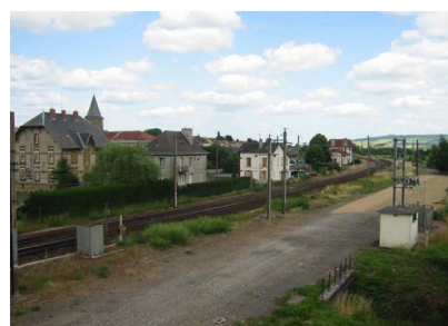
Des délaissés SNCF à valoriser.
