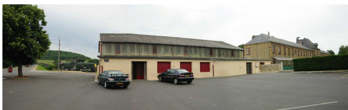
La salle Léo-Lagrange à rénover.
