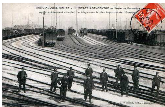
Centre de triage de Nouvion-sur-Meuse - Lumes
