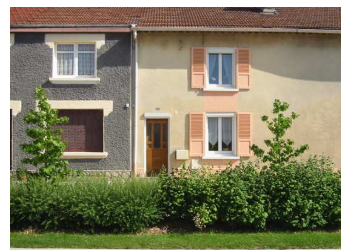
Pose de volets roulants avec un caisson proéminent sur le bâti traditionnel.
