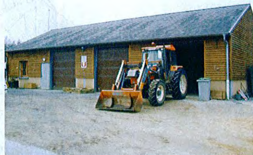
Bâtiment hébergeant l'atelier municipal et celui des pompiers
