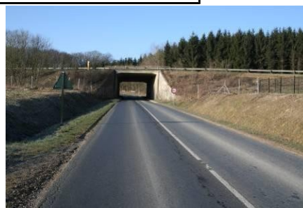
A34 pont sur RD 106
