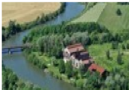
Vue aérienne : la centrale au bord de la Meuse
