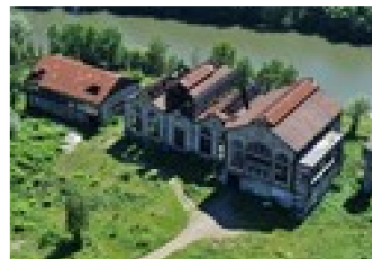
Vue aérienne de la centrale.
