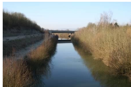
Le canal (vers l'écluse)
