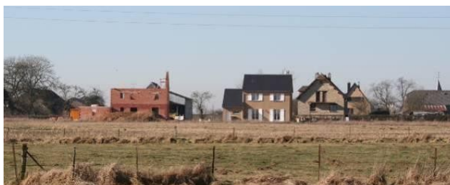
Photo 1: maison en cours de construction à Villette
