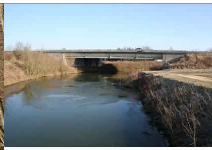
Le canal et le pont de l'autoroute
