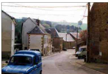
Réseau aérien très dense de certaines rues du village (Rue des Dames...)
