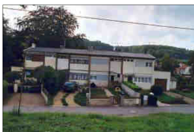
Habitat social fortement dégradé à requalifier (Cité Vieille Ville)
