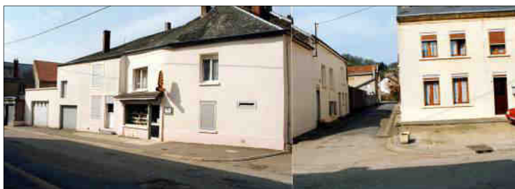
Rénovations maladroites de constructions plus ou moins récentes : enduits trop clairs, changements des proportions, volets roulants...
