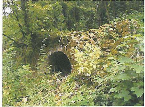
2. Four à chaux n°3
