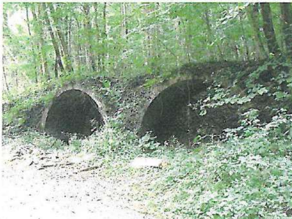
1. Vue générale du four à chaux n°1
