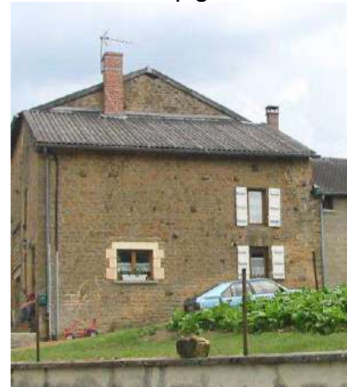
Création de fenêtre sur le pignon
