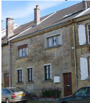
Elargissement des fenêtres à l'étage
