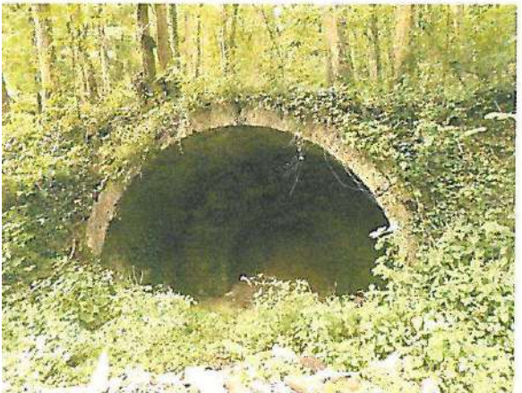
7. Four à chaux n°1
