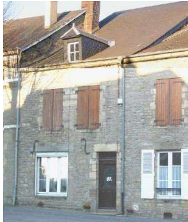
Elargissement de la fenêtre au rez-de-chaussée
