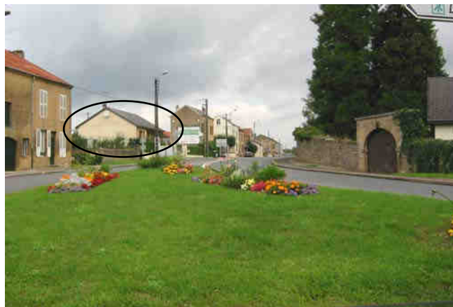
Construction récente dans une dent creuse le long de la rue de Mézières
