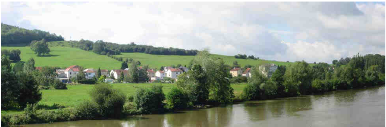
Vue sur la Meuse, l'habitat et les terrains inondables le long de la rue de Sous Rimont à partir du pont de Novion-sur-Meuse
