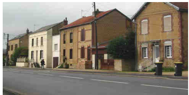
Alignement le long de la rue de Mézières
