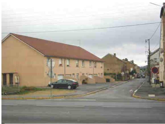
Construction récente dans une dent creuse du centre ancien (rue Roger Salengro)
