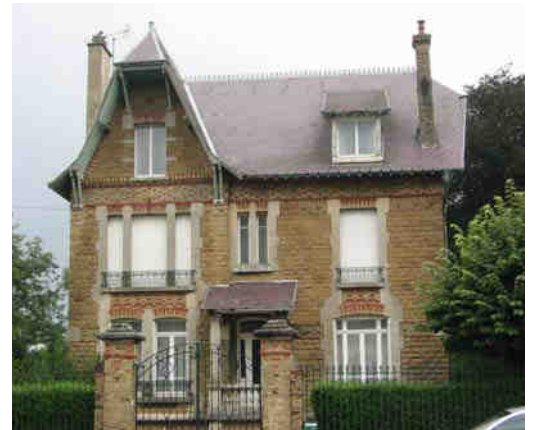
Villa de la reconstruction à pignon débordant rue de Sedan
