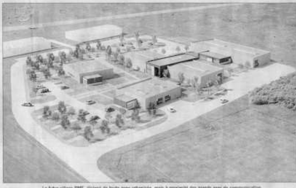
Le futur village PME, éloigné de toute zone urbanisée, mais à proximité des grands axes de communication.
