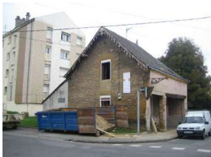
Ancien corps de garde rénové (bibliothèque)
