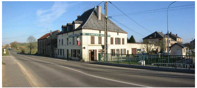
Constructions mitoyennes en bordure du canal (café et habitations).
