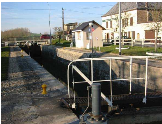
Vue sur l'écluse
