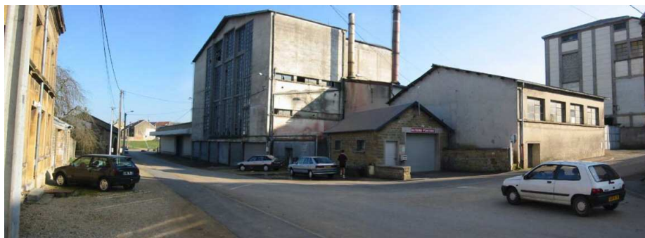
Façades dégradées et abords non valorisés de l'ancienne coopérative laitière.
