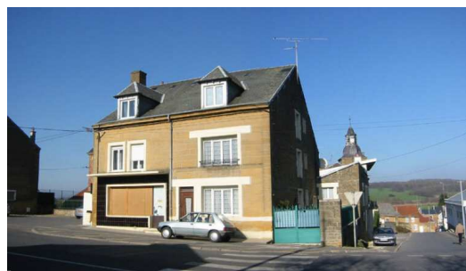
Des modifications de façades agressives ou ne tenant pas compte du support (pierre apparente, modénatures, entourages des baies,... ). Ex : mise en enduit avec des teintes trop claires, changement des ouvertures, difficultés d'intégration des devantures commerciales au bâtiment d'origine...
