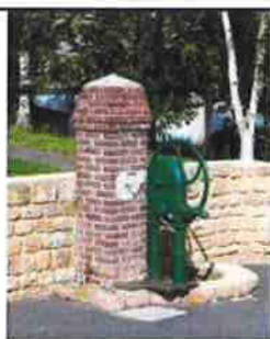
Pompe à eau à Charroué
