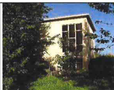
Le réservoir d'eau potable
