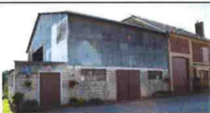
Un bâtiment en tôles ondulées jouxtant une maison en pierres et briques
