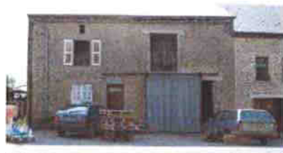
9, route nationale Une habitation de ferme en pierres
