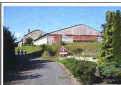
La Voie Communale n°4
