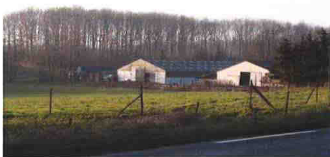
Bâtiments agricoles, à gauche en venant de Tournes
