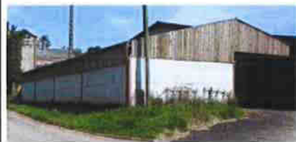
Bâtiment agricole en parpaings enduits et bardage en bois
