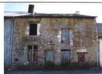
Rue des Cannes Une maison en cours de réhabilitation
