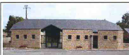
Le bâtiment polyvalent
