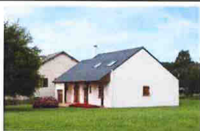
Pavillon rue de l'Enclos
