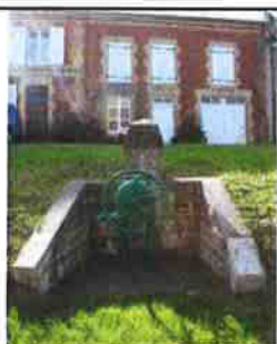
Pompe à eau à Charroué
