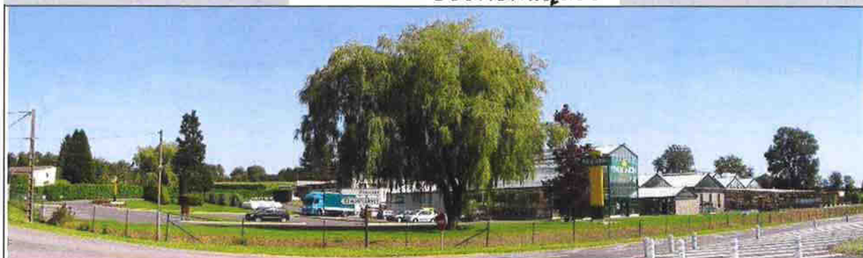
La station de distribution de carburant, à l'entrée, en venant de Charleville-Mézières
