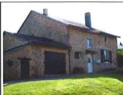
Une maison réhabilitée 5, rue des Tilleuls
