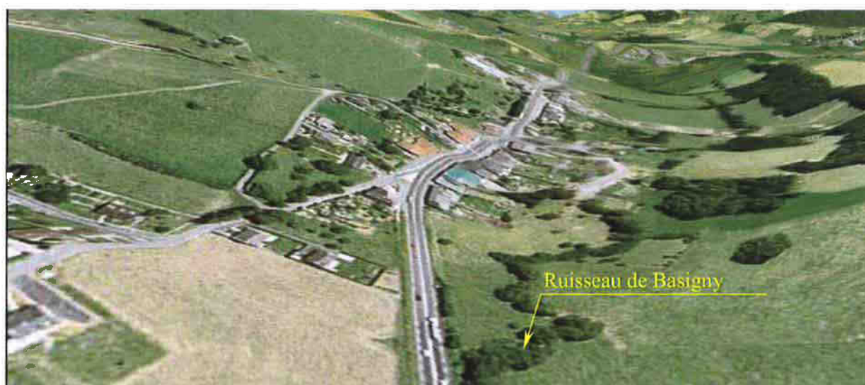
Photographie 4 : vue aérienne de CLIRON coté ouest
