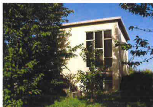
Le réservoir au lieudit "le champ aux oies"
