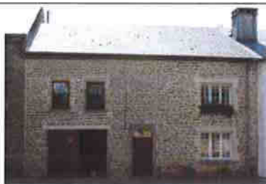
11, route nationale, une habitation réhabilitée en pierres
