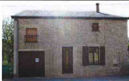
25, route nationale, une habitation réhabilitée en pierres
