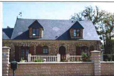
Maison nouvelle rue des Cannes
