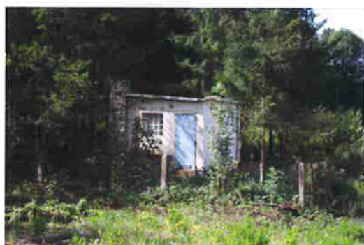
La station de pompage au lieudit "le pâquis"
