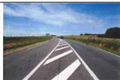
La R.D. n° 40 bis au rond point du Bois de La Loge
