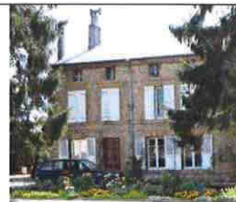
7, route nationale Une habitation de ferme en pierres
