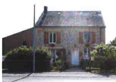
3, route nationale, une habitation en pierres et briques pour l'appentie
