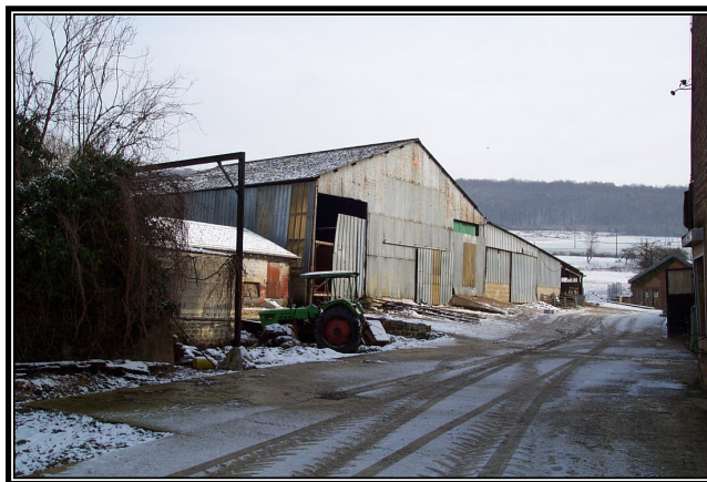
Bâtiment en tôle méritant un effort d'intégration Vue depuis la RD 977
