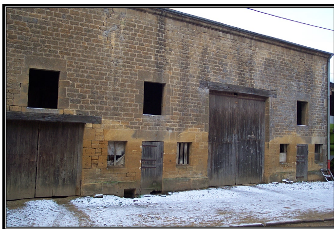
Corps de ferme à restaurer Rue de la Tranloye
