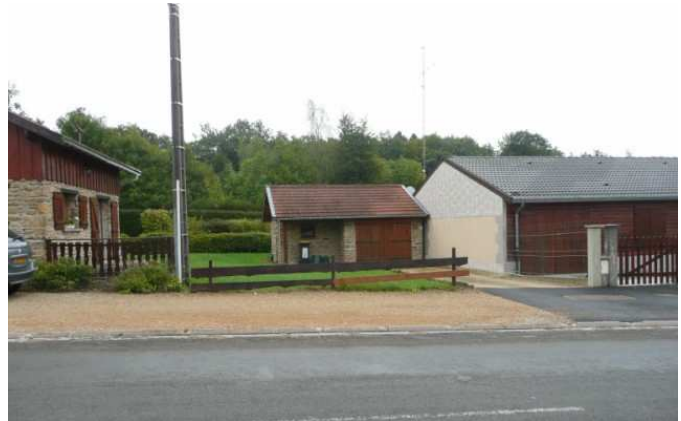
Vue côté Est, en face du home d'accueil
