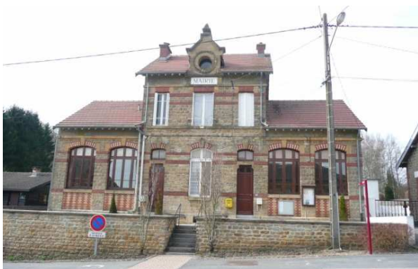
Mairie et logement communal
