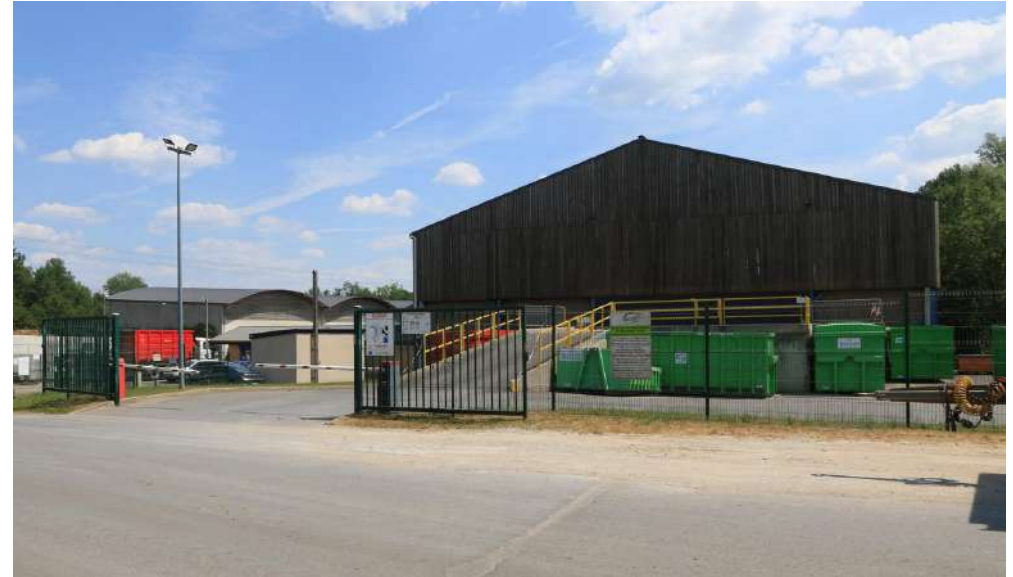
Les installations techniques d'ARCAVI - Bois, métal et béton
