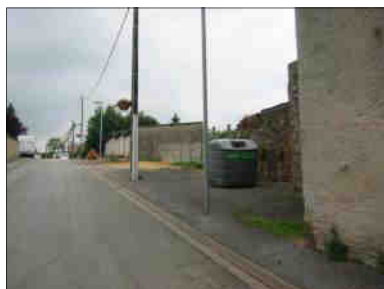
Réseau aérien dense de certaines rues : Poursuivre leur enfouissement en cas de travaux d'aménagement.
