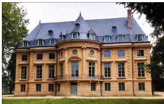
Vue sur la façade arrière
