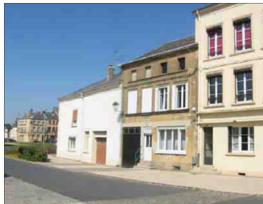
Rénovations maladroites : enduits trop clairs, modifications des ouvertures, pose de volets roulants à caisson proéminent, ...
