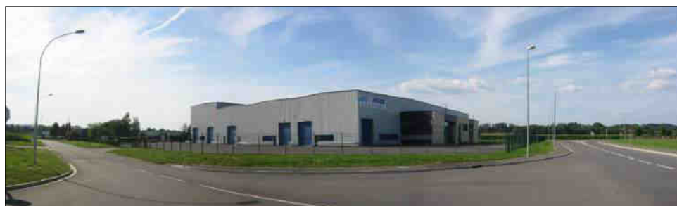
Emile de l'Hamaide S.A. ( installée auparavant à La Moncelle )
