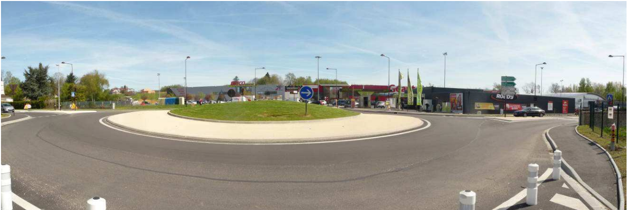
Vue sur le giratoire depuis la branche d'accès à la future zone 1AUy
