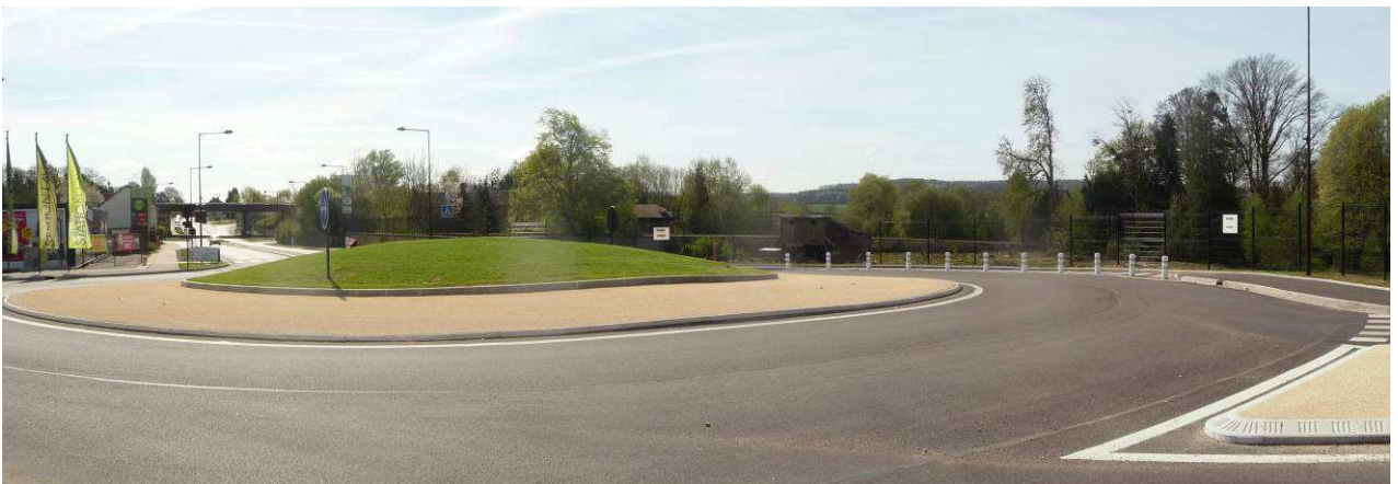
Vue sur le giratoire en venant de Sedan et/ou du centre de Balan, avec, à droite, le futur site à urbaniser
