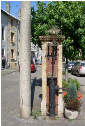
Pompe, rue de l'église
