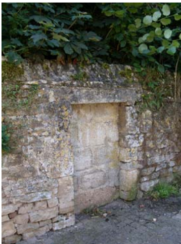
Mur en pierres sèches rue Warnesson
