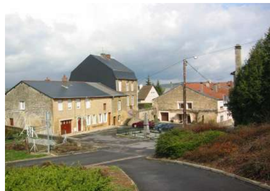
Absence de traitement qualitatif des espaces publics, ne mettant pas en valeur un bâti traditionnel de qualité, et offrant peu de lieux de convivialité.
