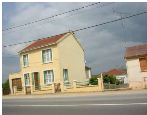
Modification des ouvertures, devenues horizontales
