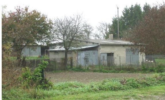
des constructions disparates,
