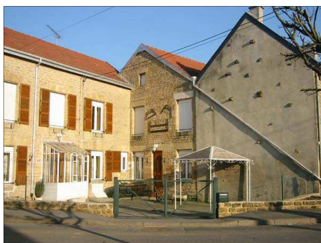
Voie des Prés : Espace commun aménagé face à l'ancienne école.
