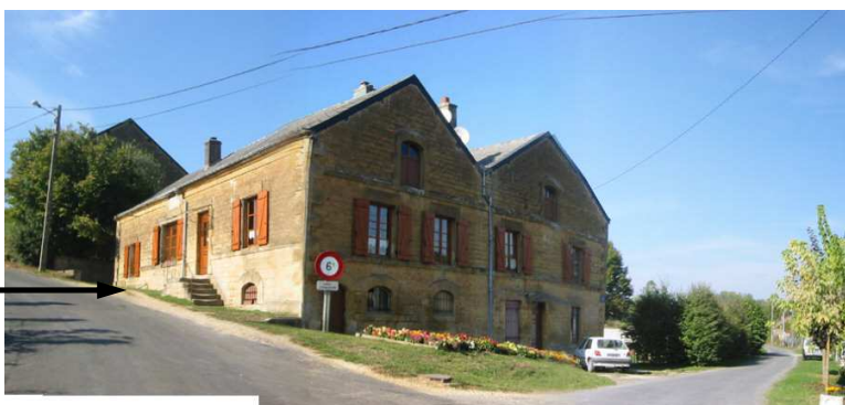
Réhabilitation réussie de cette habitation à l'angle du chemin du Poirier Jay et de la voie communale des Crayers. La construction épouse les courbes de niveau.
