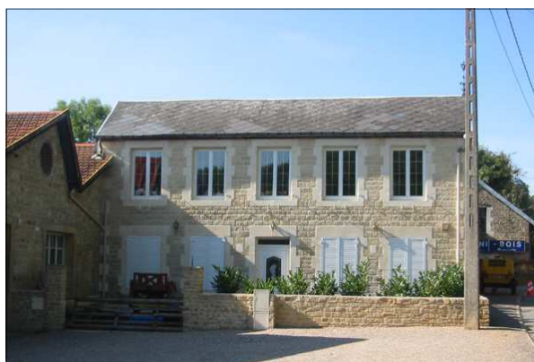
Maison d'habitation attachée à la " filature moderne ", et dont la réhabilitation réussie mérite d'être signalée.
