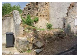
Dépôt de gravats au cœur du village (friche urbaine partiellement démolie)
