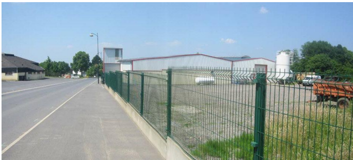
Vue sur les Ets Thiry depuis la rue Marcel Dorigny réaménagée et à gauche la salle polyvalente
