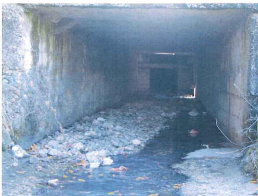
Vue du ruisseau de Merdan canalisé
