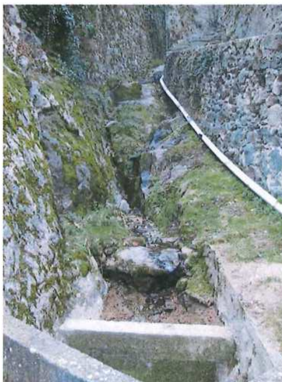
Départ canalisé du second talweg au Sud
