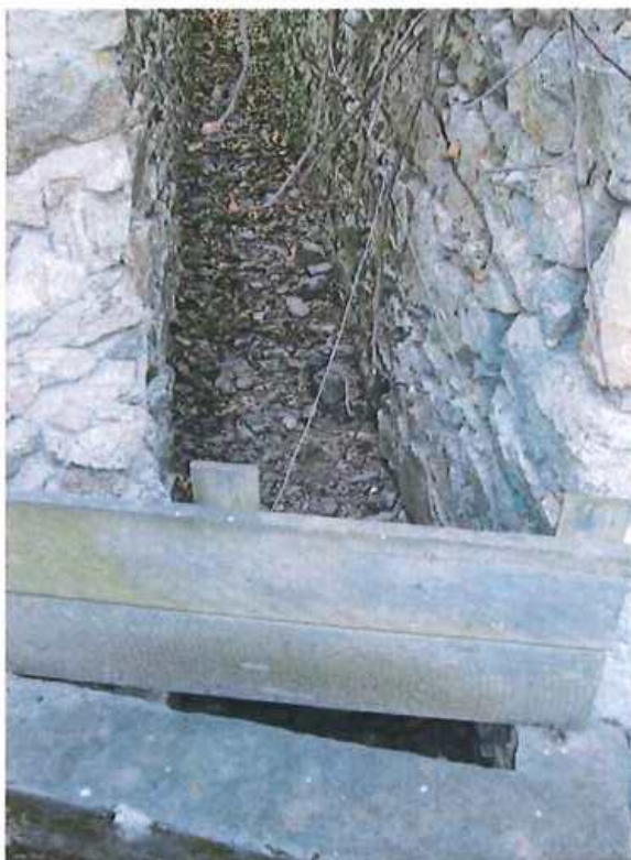
Départ canalisé du talweg le plus au Sud
