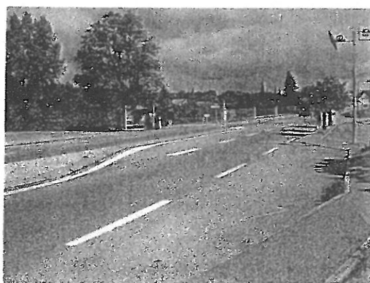
Croisement RD 104 - RD 423 : Accès à la commune
