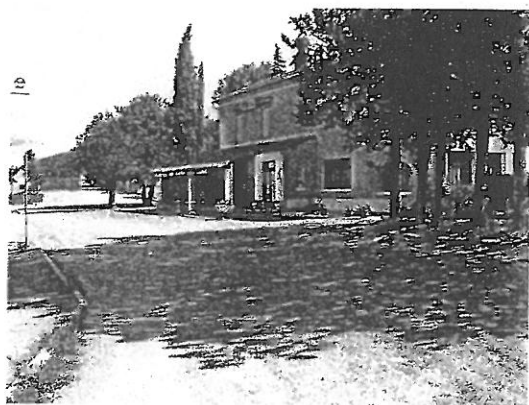
Commerce situé le long de la RD 104
