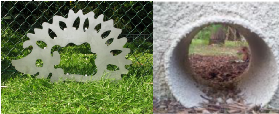
Figure 3 - Exemples d'ouvertures dans un grillage et un muret prévues pour le passage de la petite faune (Source : U2B - Limiter l'impact des clôtures sur la biodiversité, 2014)
