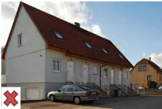
1. Absence de transition
