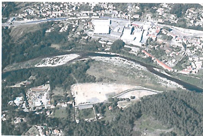
Site de Chamboulas
