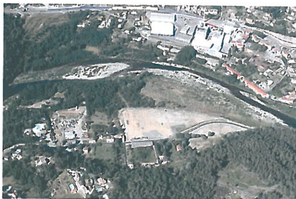
Vue sur la future zone d'activité et le camping
