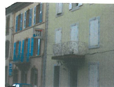
Façades rénovées boulevard Stalingrad
