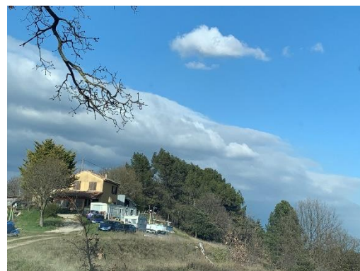
Lieu-dit « le Beau » sinistré, habitat précaire en attente d'autorisation de reconstruire
