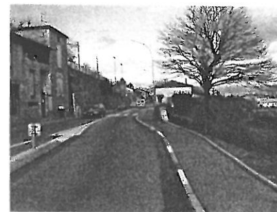
La traverse du village (RD579)
