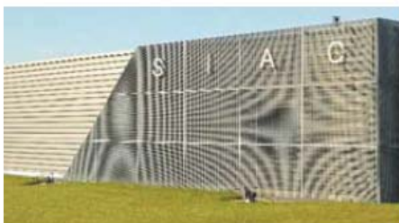
► Traitement de façade mettant en valeur un dispositif d'enseigne sobre et élégant (Lettres découpées en métal) Atelier de cablage à Andrézé (49) P. Bossard architecte.
