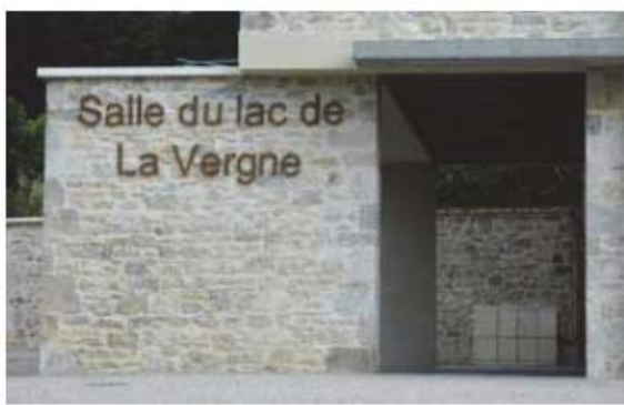
► Une enseigne en lettres découpées s'installe sur un volume dont le décrochement marque l'entrée du bâtiment - Caillac (46) P. Bosc architecte
