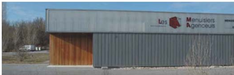
► Bardé en bois, un retrait ménagé dans la façade marque l'entrée du bâtiment. Le bandeau d'éclairage en polycarbonate est le support de l'enseigne - Entreprise de menuiserie à Villesèque (46) - Architecte Franck Martinez
