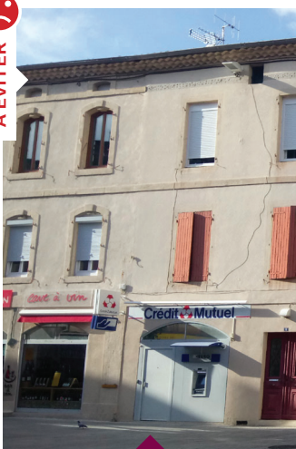
Dans cet ensemble, les interventions successives sur les menuiseries ont banalisé le caractère de la façade ( suppression des volets, volets roulants parfois avec caisson apparent, volets pliants,...).
