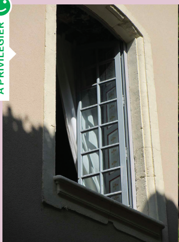
Les menuiseries doivent s'adapter à la forme des percements dans lesquels elles s'insèrent (1). Les poses 'en rénovation' sont à éviter (2).
