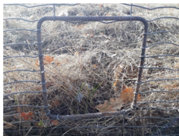
Trouée à la base de la clôture permettant le passage de la petite et moyenne faune.
