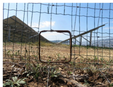
La mise en place de cadres en fer au niveau de ces trousés est important pour renforcer le dispositif sur un temps long.
