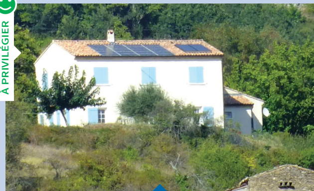
Panneaux intégrés à la pente du toit
