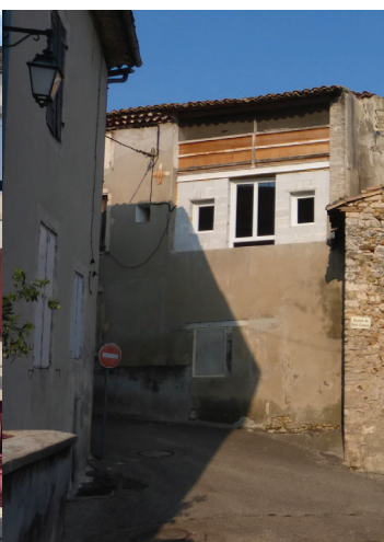
Dans cet ensemble, les interventions successives sur les menuiseries ont banalisé le caractère de la façade ( suppression des volets, volets roulants parfois avec caisson apparent, volets pliants,...).
