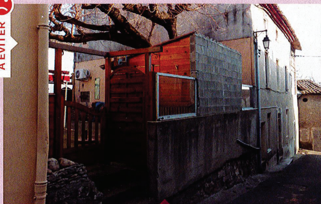
Les ajouts isolés cassent la composition d'ensemble. Le manque de finition du volume rapporté et la juxtaposition d'éléments disparates nuisent à l'harmonie visuelle.
