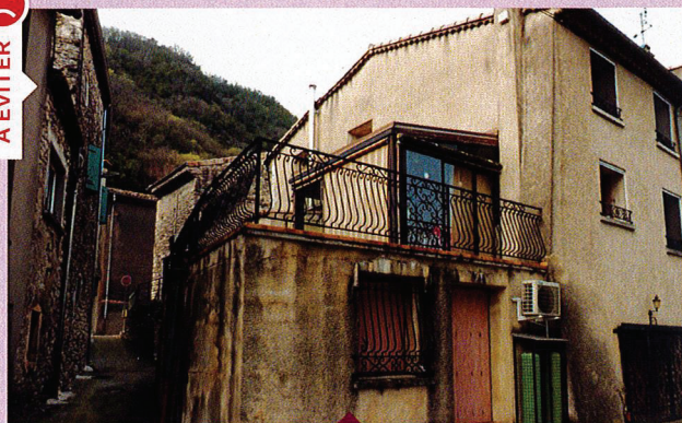
Les ajouts isolés, le style du garde-corps, les éléments divers (climatiseur, bouteilles de gaz) déséquilibrent l'aspect général, la vue est brouillée par ces différents obstacles visuels. Le tout manque d'homogénéité.
