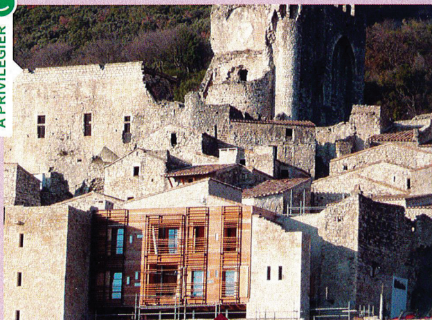
La partie créée est en bois, ce qui permet de différencier l'existant du neuf. Le volume rapporté s'insère parfaitement ; il respecte les hauteurs existantes. Les ouvertures reprennent l'esprit des ouvertures anciennes.
