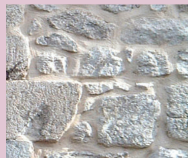
Joints à la chaux
