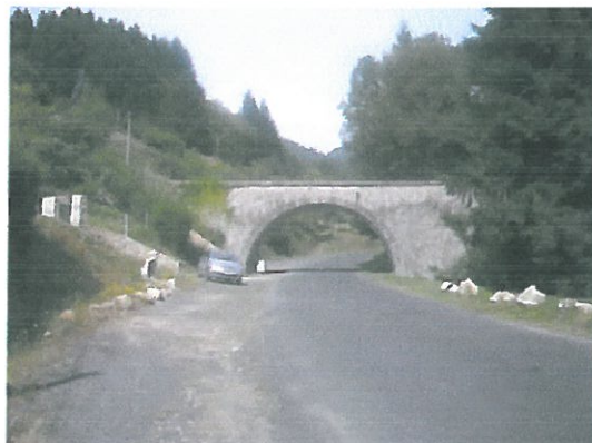
L'ancienne voie ferrée marque l'entrée du hameau.
