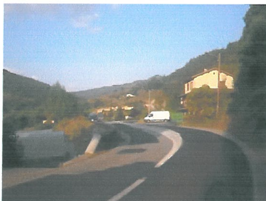
L'entrée est de Valamas, en provenance de Saint-Martin
