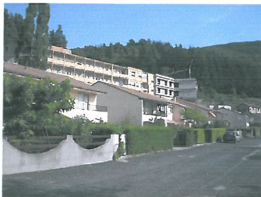
Lavis : maison de retraite et son extension
