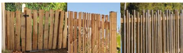
Clôtures en bois d'aspect brut (non peint), ajourée et constituée de lames verticales
