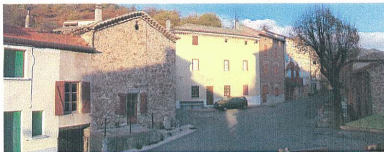
Vue sur le carrefour du centre bourg
